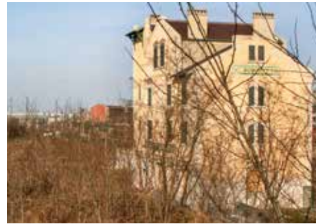
Ancienne gare de déportation Bobigny (Seine-Saint-Denis)
