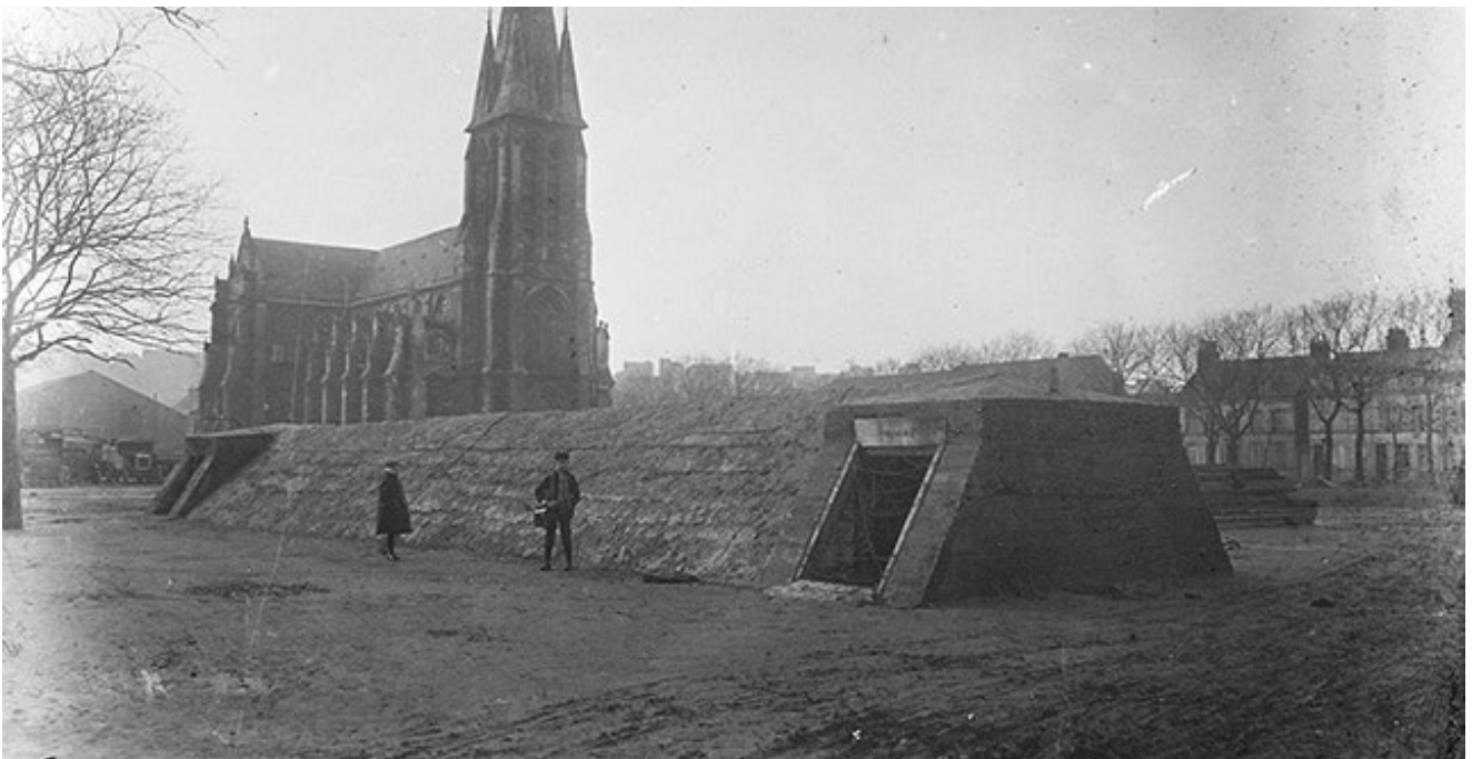
Place de Capécure, abri en béton, 1917-1918.
