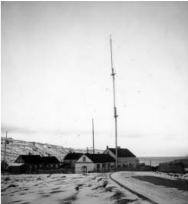
Le poste émetteur de Saint-Pierre.
