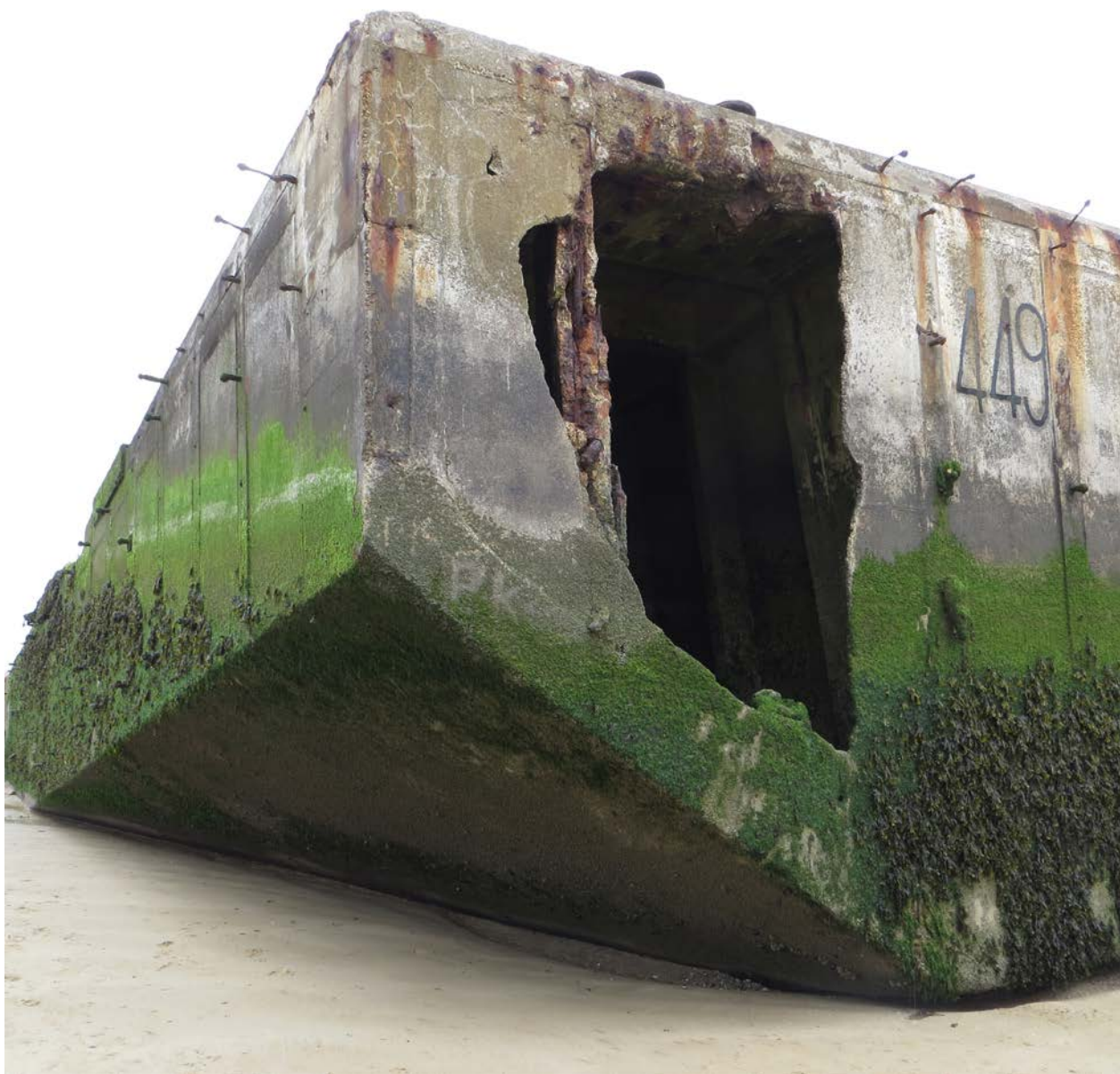
Les caissons Phoenix sur la plage d'Arromanches
