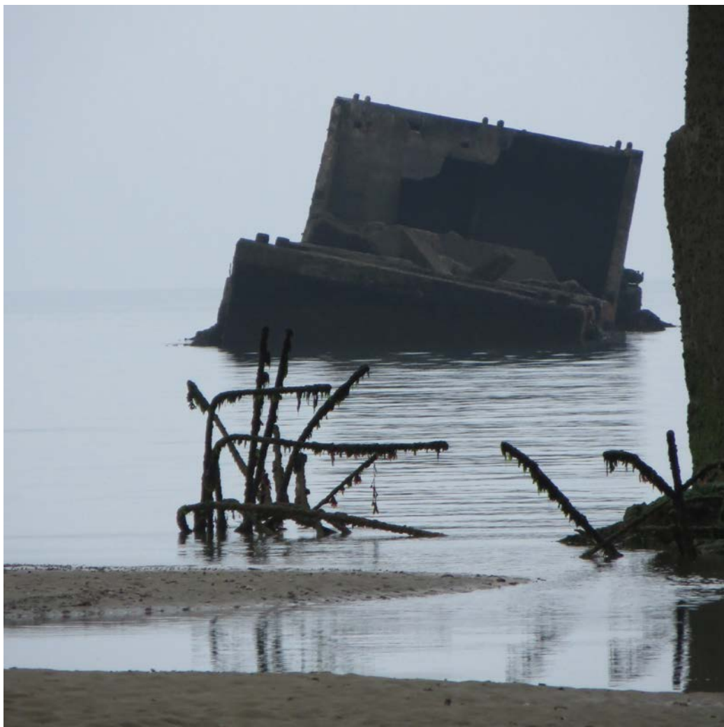
Des caissons lugubres...
