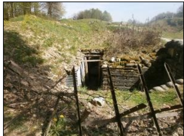
Tranchée allemande : les soldats ont utilisé du béton pour renforcer leurs tranchées
